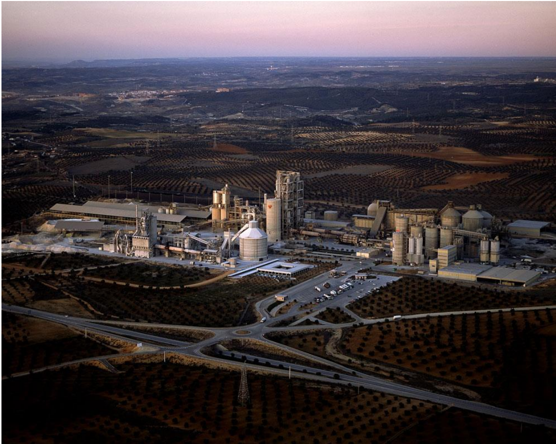
Fábrica de cemento de El Alto, propiedad de la empresa CEMENTOS PORTLAND VALDERRIBAS (del grupo empresarial FCC), en Morata de Tajuña (Madrid)
