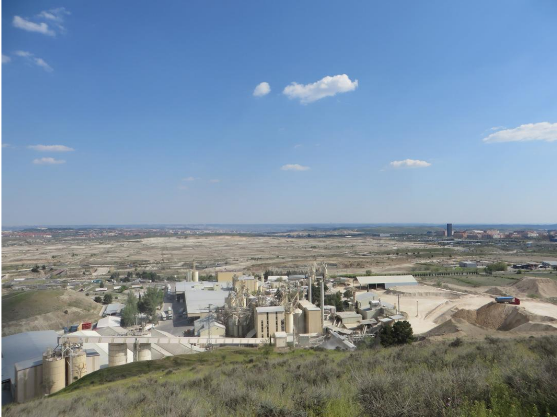
Fábrica de soluciones minerales, propiedad de la empresa TOLSA, situada en... (paisaje industrial visto hacia este, IMAGEN PRINCIPAL A COMENTAR )
